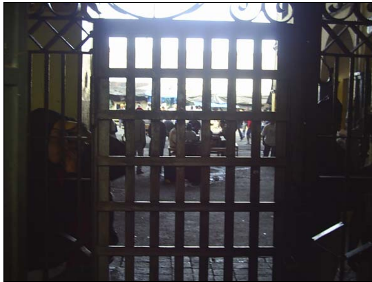
Foto 6: Puerta de ingreso Pabellón de Detenidos Cárcel de Varones de Cuenca, 19/09/07
