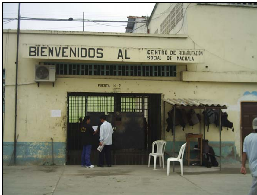
Foto 2: Ingreso a pabellones, Centro de Rehabilitación Social de Machala, 03/10/07
