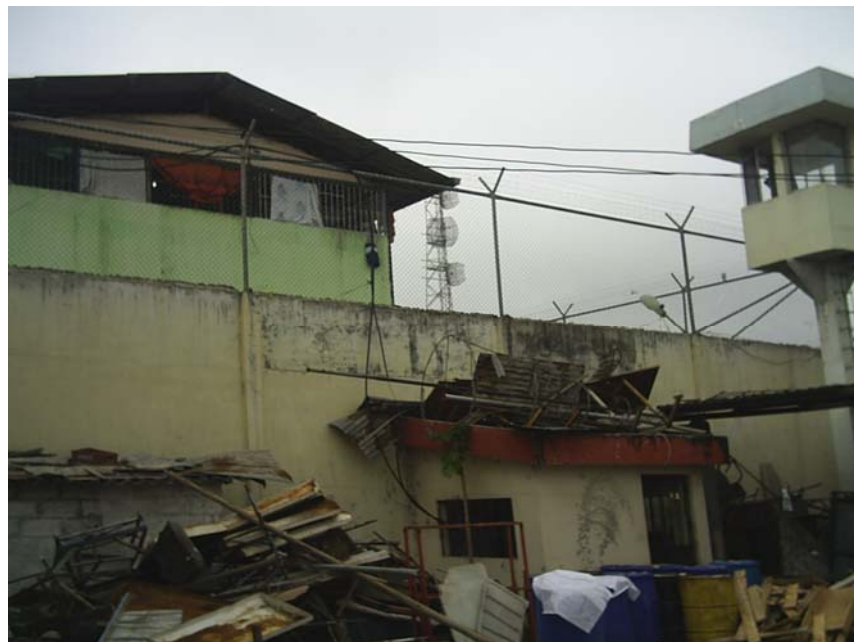
Foto 4: Celdas de prisionizados planta alta, Centro de Rehabilitación Social de Machala, 03/10/07
