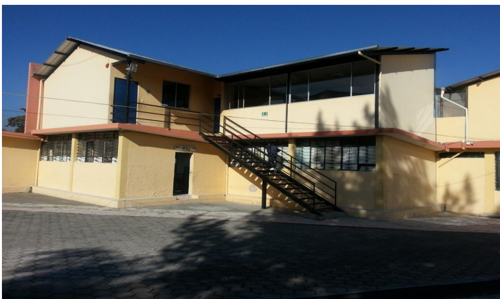
Foto 1 En la planta baja se puede notar dos aulas en la una será la oficina donde va estar la Coordinadora del CAANE organizando las actividades diarias y en la otra el aula del CAANE es donde van asistir los niños con Necesidades Educativa Especiales
