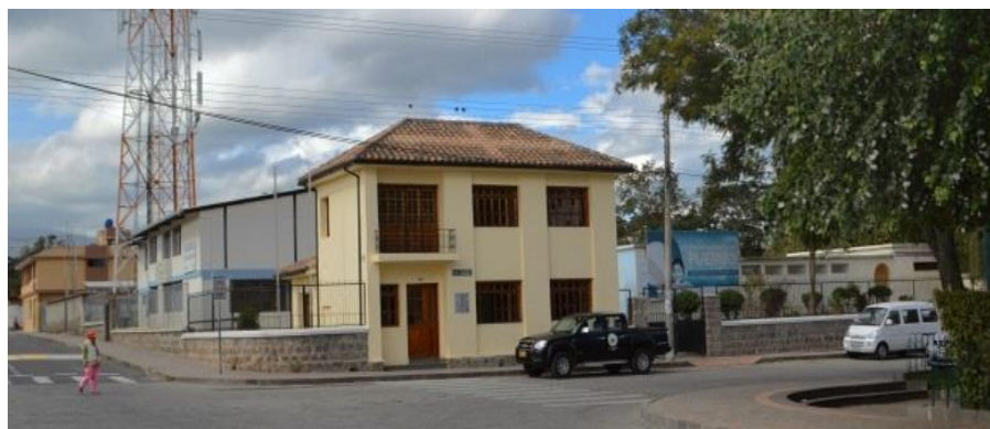
Figura 11 Instalaciones del GAD de la Parroquia Pumbo
