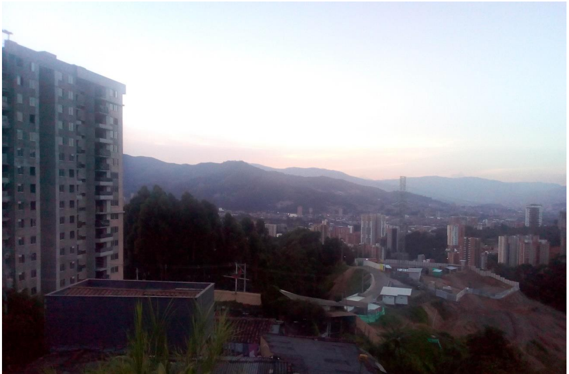
Ilustración 11. Construcción de torres urbanísticas en la vereda San José Fotografía: Arlex Castaño, 2018
