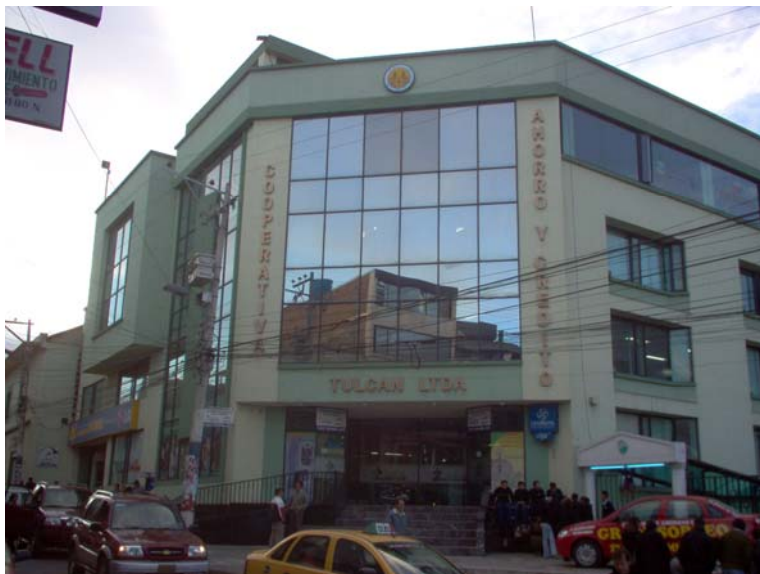
ANEXO II: Edificio de la Cooperativa Tulcán en la misma ciudad.
