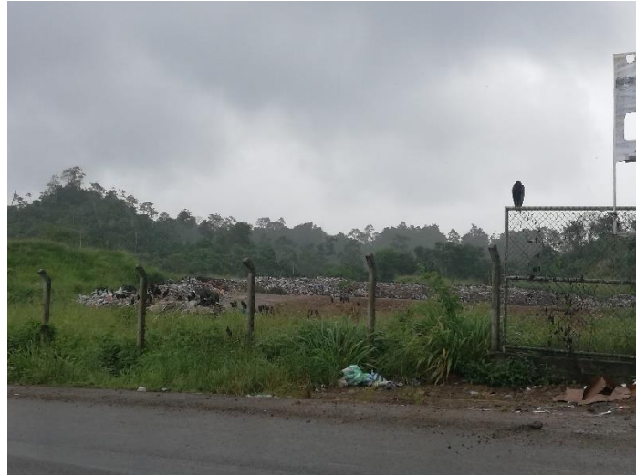
Figura 9. Botadero a cielo abierto del Cantón Eloy Alfaro
