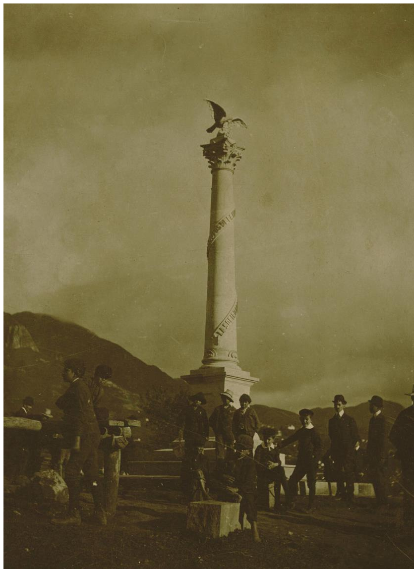
Figura 9. Columna a los héroes ignotos en el Parque del Centenario, 1910. Colección Urna Centenaria, Archivo de Bogotá.
