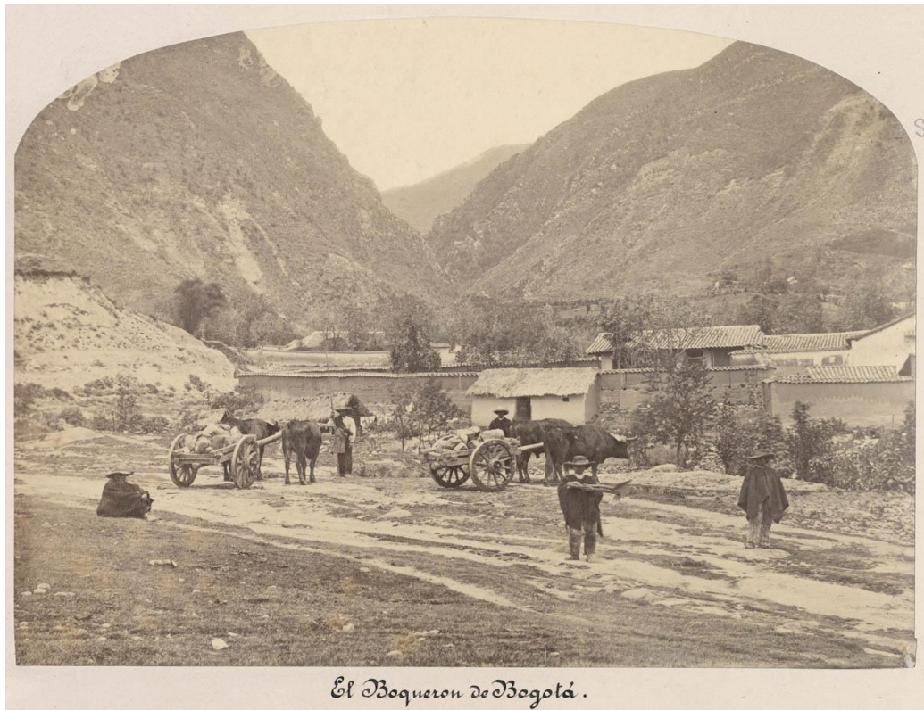
Figura 2. El Boquerón de Bogotá . Fotografía tomada del archivo del Leibniz Institute for Regional Geography.
