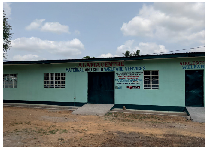
Figs. 5 y 6. Imágenes del proceso constructivo —durante la construcción y al finalizar— del centro sociosanitario Alafia.
