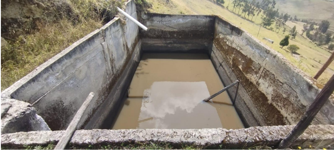
Área de producción en el sector de El Quinche, reservorio que capta aguas de las cunetas que recogen el agua lluvia de terrenos y vías de tercer orden.
