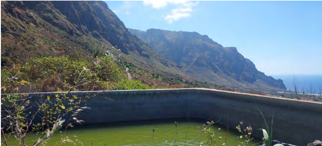
Fotografía 23. Deposito para recoger el agua de la lluvia y para llenarlo de agua comprada
