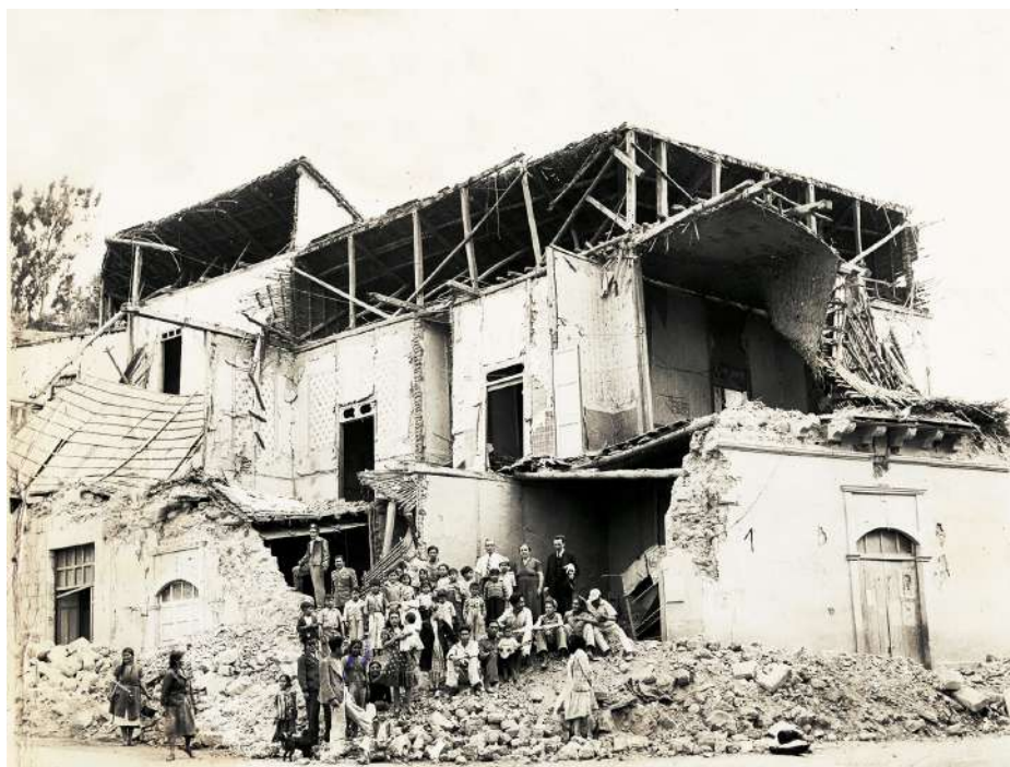
Figura 1. Una casa en la plaza [Urbina] en Ambato. Escuela de Totora
