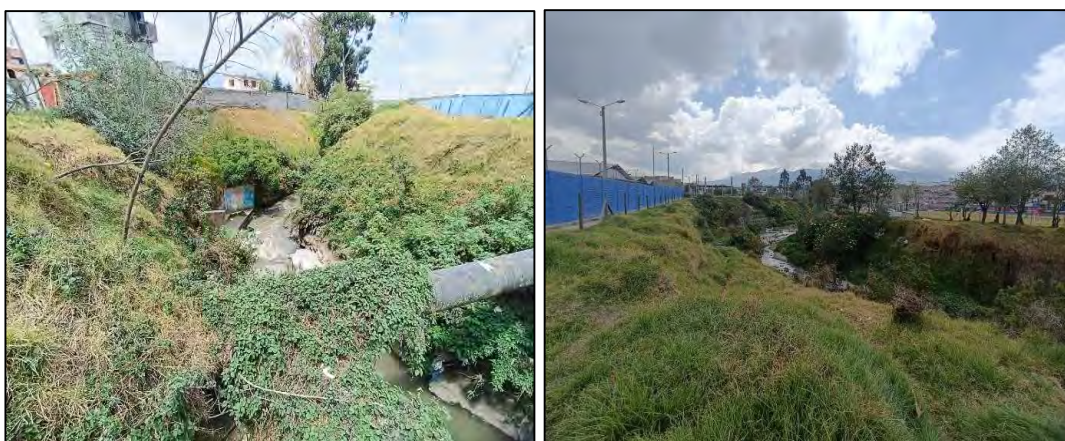
Figura 25. Tramos de la quebrada Shanshayacu y viviendas cercanas Fuente: fotografías tomadas durante las visitas de campo en noviembre 2024
