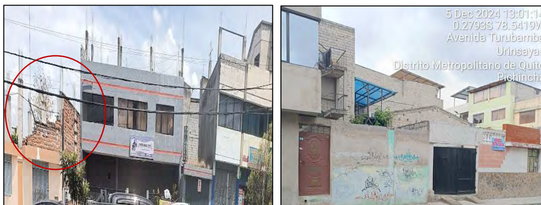
Figura 24. Ejemplos de estructuras habitacionales con deterioro, Turubamba Bajo Fuente: fotografías tomadas durante las visitas de campo en diciembre 2024
