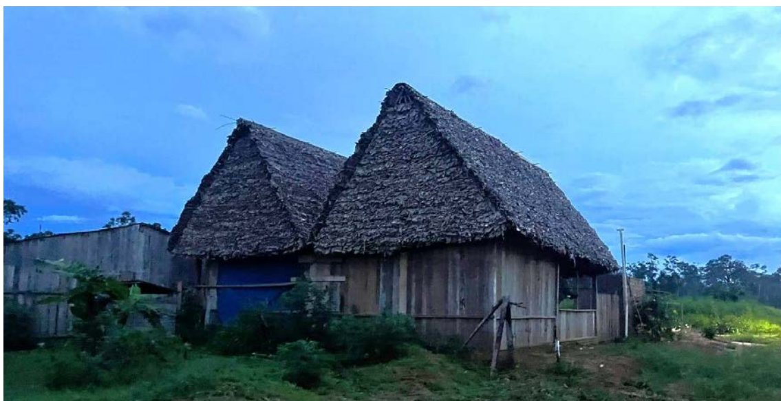
Figura 16. Construcción tradicional, muros de madera y techos de jatata, 2025. Elaboración propia.
