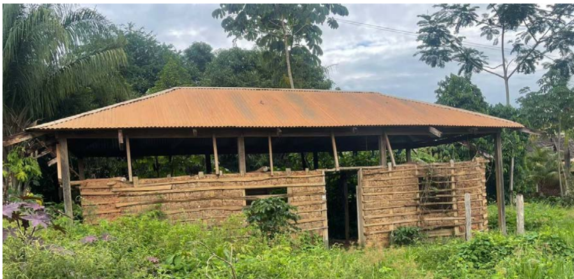
Figura 15. Construcción mixta, técnica tradicional con tierra en muros y calamina en techos, 2025. Elaboración propia.
