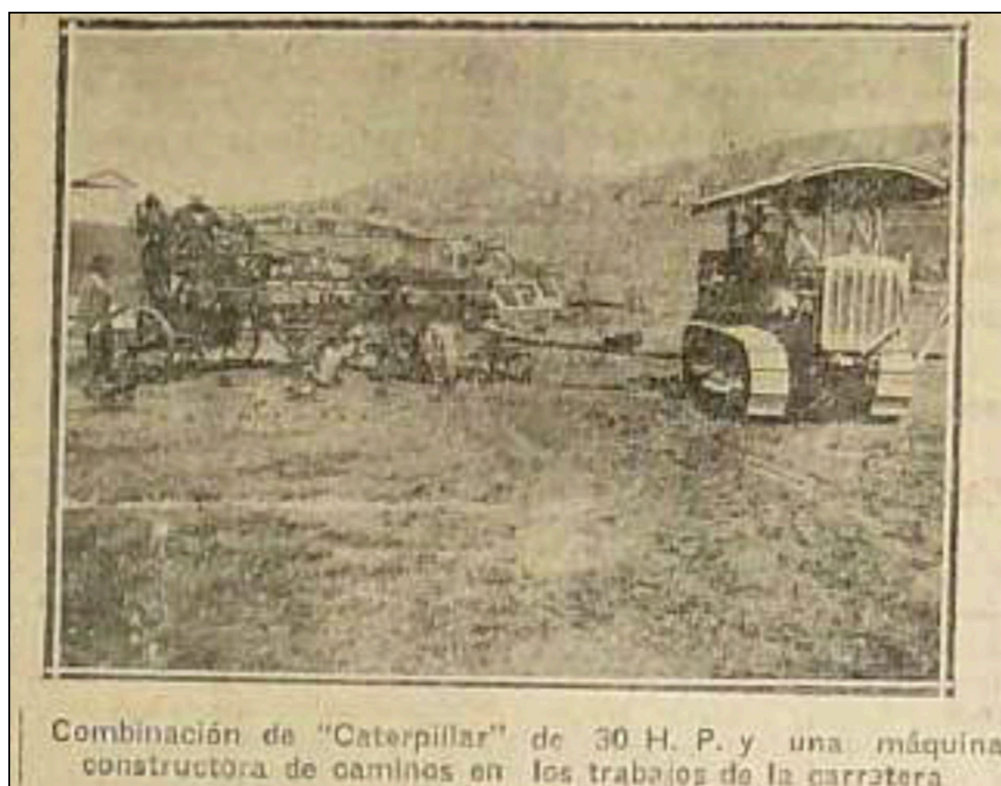
Figura 15. Maquinaria para reparación de caminos en el sitio Carretas (1930)
