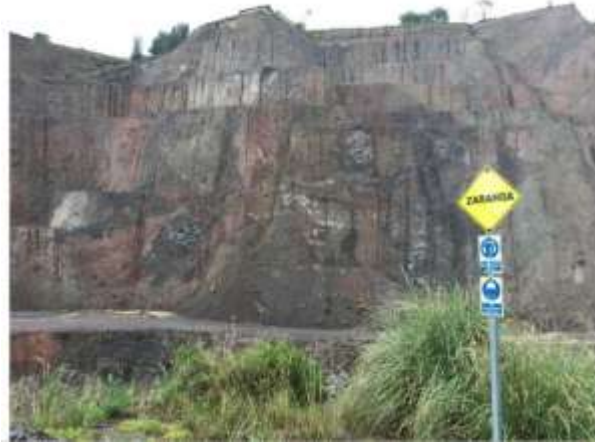
Figura 14. Terraceo del suelo en Cantera “Miraflores de Guano” Fuente: Fotografía de GAV.
