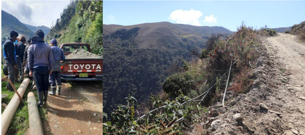
Imagen 3 Entubado de agua desde la parte alta de la microcuenca en Palca para la distribución de agua para la agricultura familiar y campesina
