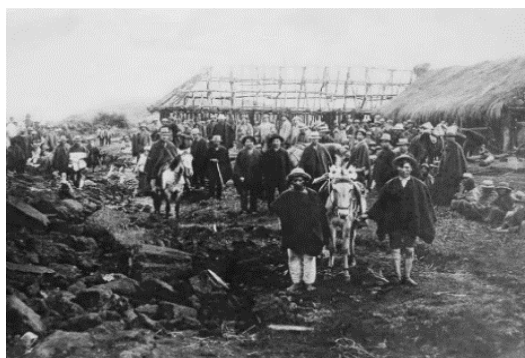
Imagen 13. Construcción del nuevo centro urbano en el Llano de Piedras (Cumbal Nuevo) luego del terremoto de 1923.
