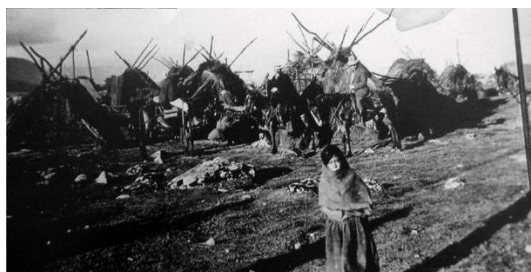
Imagen 12. Construcción del nuevo centro urbano en el Llano de Piedras (Cumbal Nuevo) luego del terremoto de 1923.
