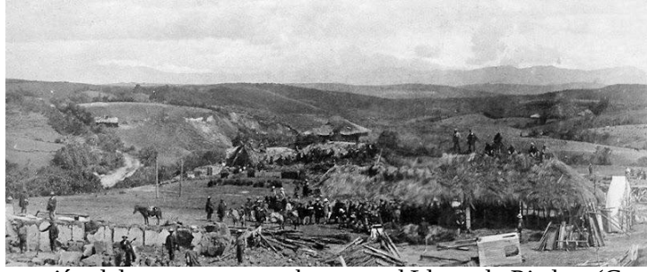
Imagen 14. Construcción del nuevo centro urbano en el Llano de Piedras (Cumbal Nuevo) luego del terremoto de 1923.
