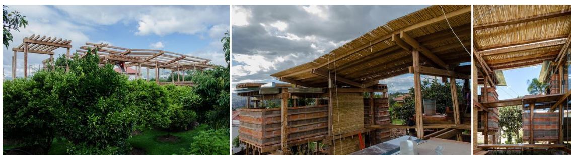
Figura 34. Vigas de madera recicladas en Casa en el Carrizal, 2015.
