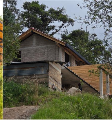
Construcción con Adobe y Madera
