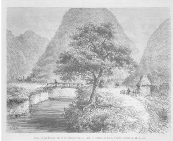
“Puente de las Juntas, sobre el río Dagua”. E. Riou. 44
