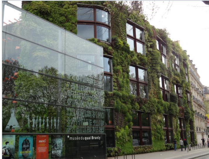
Fotografía 5.2.2. Edificio secundario del museo (Branly). Fuente: propia de la investigación, 2014.
