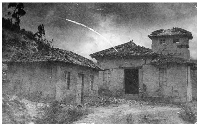
Estado en que quedó la Casa de la Administración de la Planta Eléctrica de Pelileo luego del terremoto. Fuente: Galo Torres.
