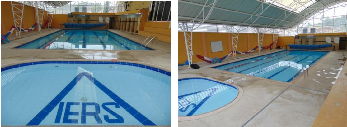
Figura 5 Registro fotográfico de área de piscina
