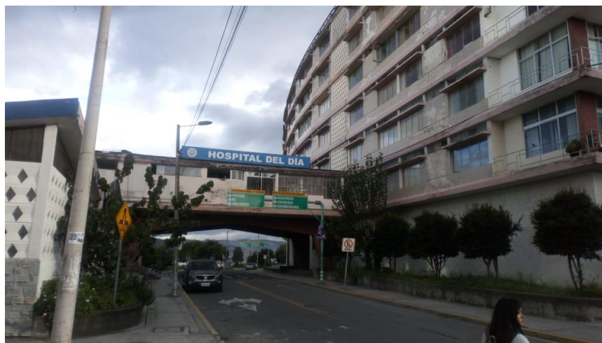
Figura 2. Edificio en el que funciona actualmente el Archivo General de la UCE Elaboración: Pamela Mera Salas
