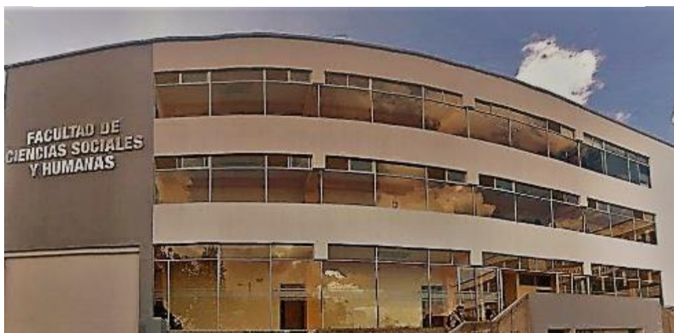
Figura 3. Edificio de facultad universitaria
