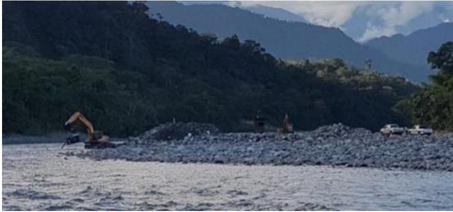
Figura 8. Maquinaria trabajando dentro del río Aguarico. Fuente: Comunidad A'í cofán, Sinangoe.
