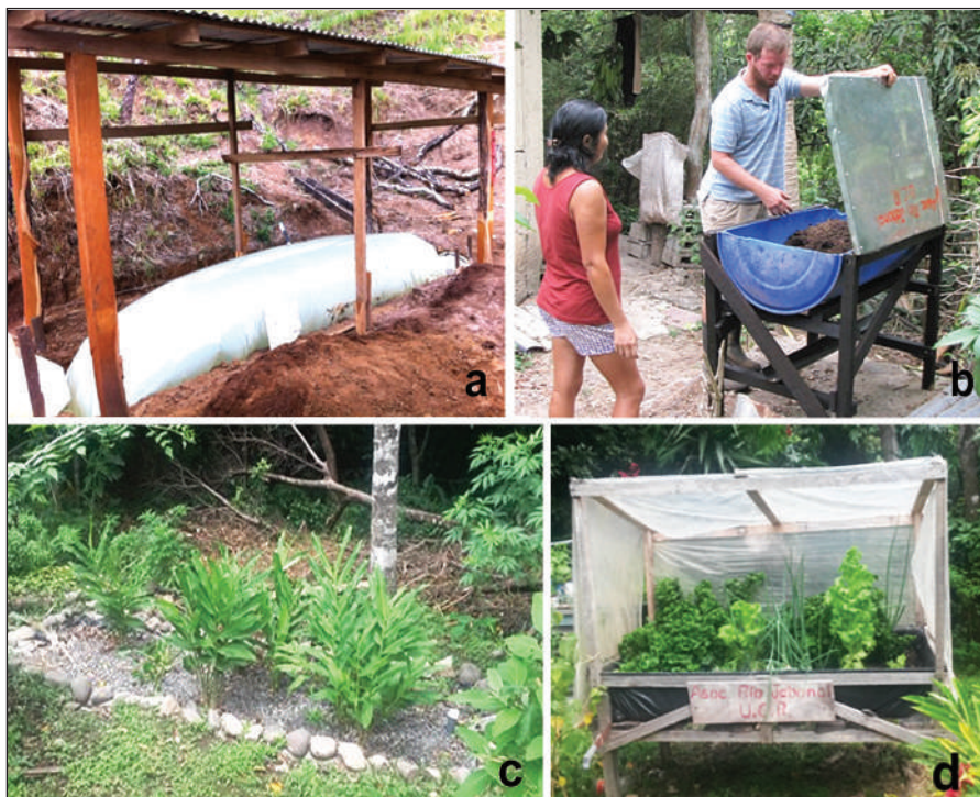
Figura 4 Ecotecnologías construidas en la subcuenca del río Jabonal (biodigestor [a], abonera [b], biojardinera [c] y microinvernadero [d])
