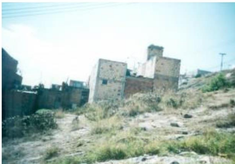
Anexo 6: foto del Terreno para construcción de la CESW, 2002 Imagen: http://www.ceswaldorf.org/w/historia/#p-718 .
