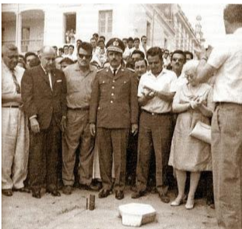
Imagen 11. Colocación de la primera loseta en la calle Libertad, septiembre de 1966. Foto de archivo cortesía de Alfredo Román
