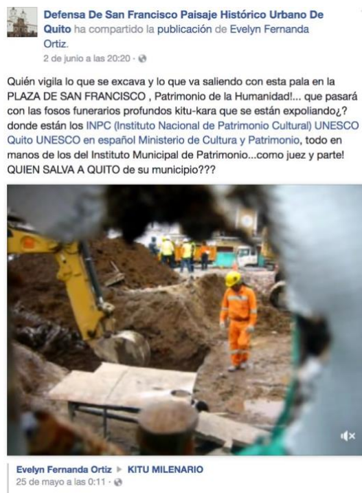
Figura 4. Detalle Excavación , Construcción estación de metro Plaza de San Francisco, 2016 Pantallazo tomado del Grupo de Facebook Defensa de San Francisco Paisaje Histórico Urbano de Quito. "Quién vigila lo que se excava y lo que va saliendo con esta pala en la PLAZA DE SAN FRANCISCO, PATRIMONIO DE LA HUMANIDAD... qué pasará con las fosos funerarios profundos kitu-kara que se están expoliando¿?..
