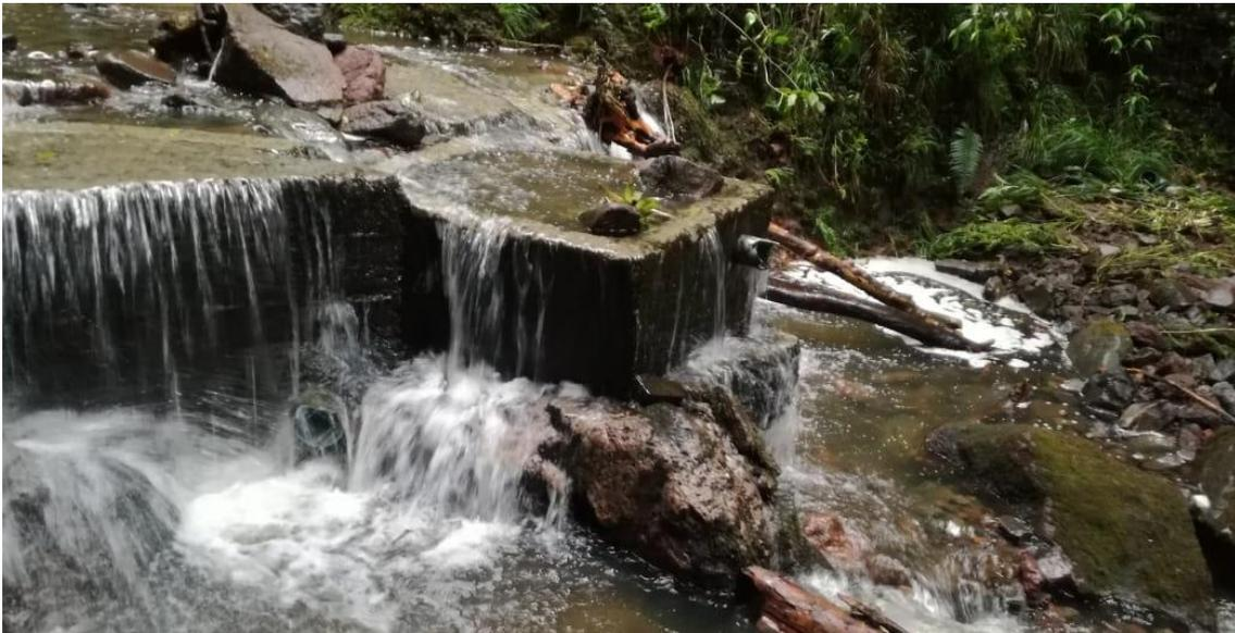
Figura 17. Agua desbordándose en la captación Santa Martha en época invernal por taponamiento causado por acumulación de sedimentos.
