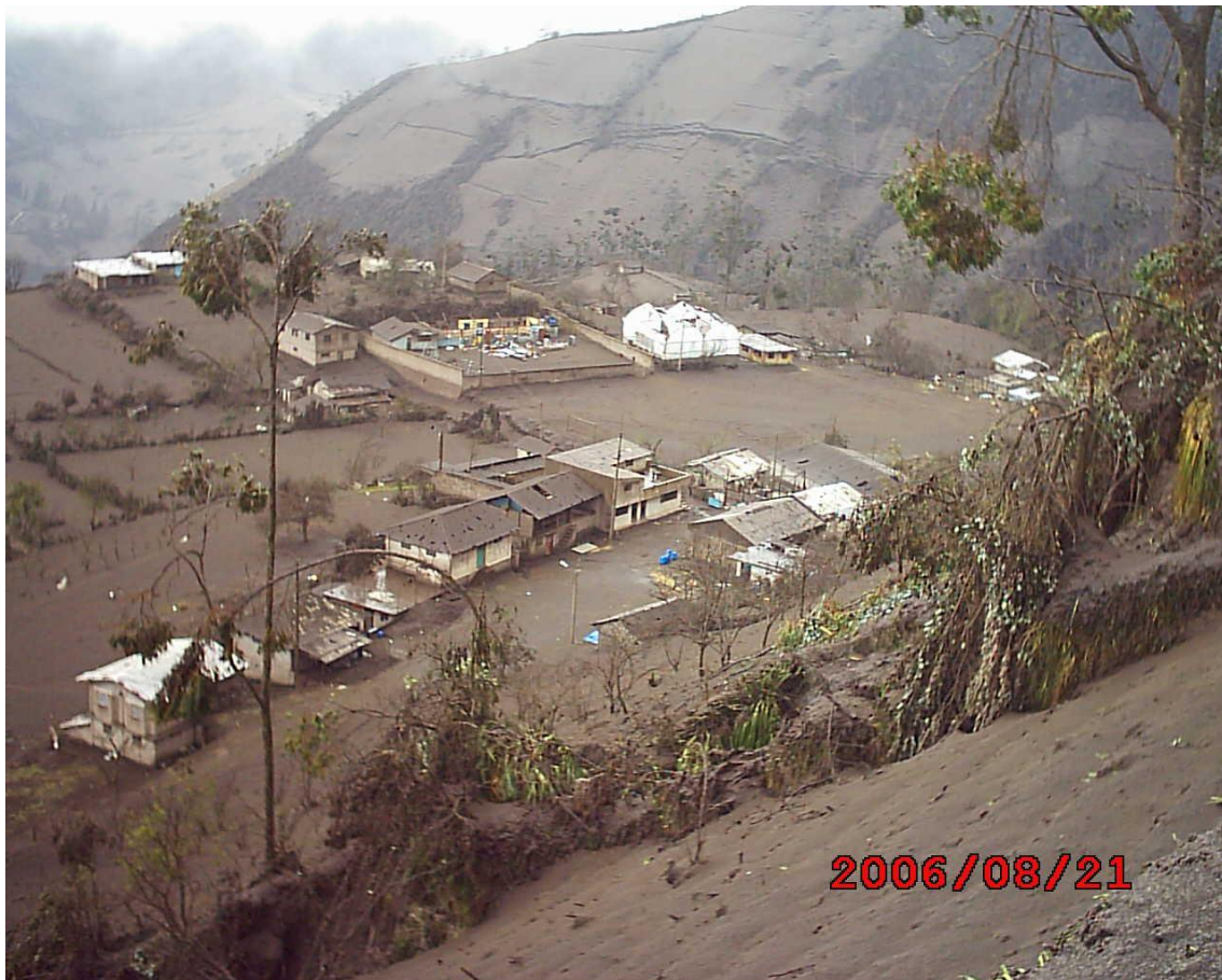
Figura 2. Daños provocados en la comunidad de San Juan, parroquia Cotaló, cantón Pelileo de la provincia del Tungurahua, por la erupción del volcán Tungurahua del 16 de agosto de 2006. Fotografía tomada por L. Troncoso, 2006.
