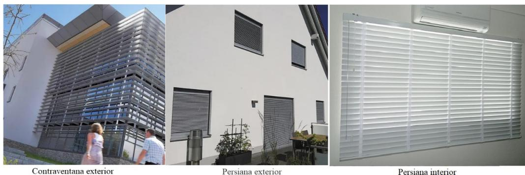
Figura 10: Protección horizontal en fachadas y ventanas
