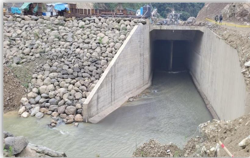
Figura 16. Construcción de túnel para el desvío del río Ivirizu, 2022
