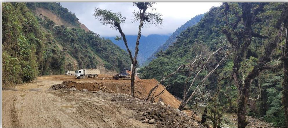
Figura 14. Maquinaria removiendo la tierra para su posterior traslado como parte de los agregados en obra hidroeléctrica Ivirizu, 2022
