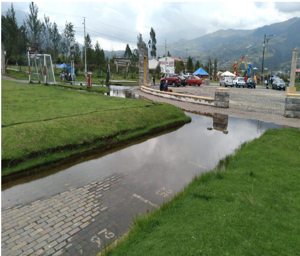
a) Inundaciones registradas en el Parque Acuatices Araque, abril 2023.
