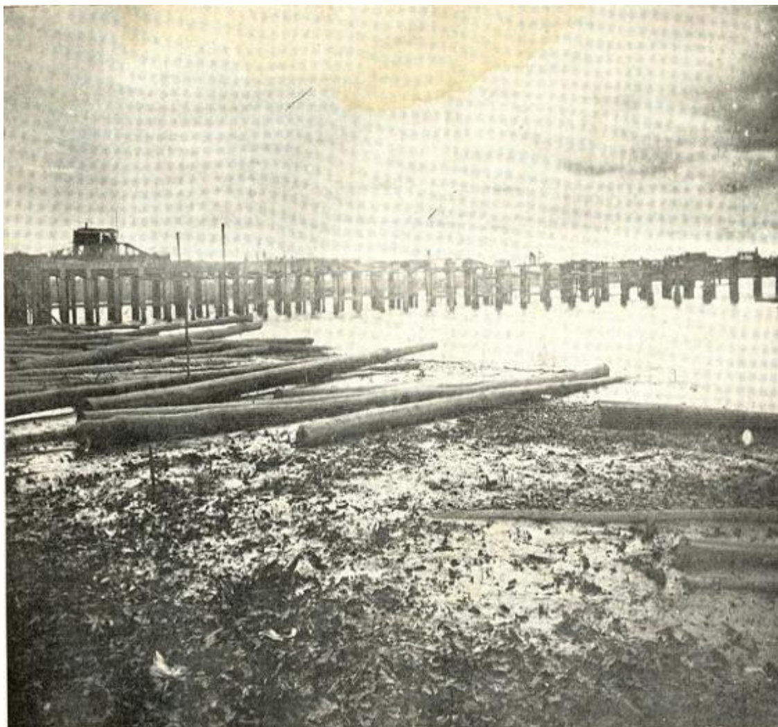
Fotografía 30. Aspecto de la construcción del muelle del puerto de Buenaventura. Obsérvese la marea baja. Buenaventura, 1906. Tomado de la Biblioteca Departamental Jorge Garcés Borrero, Fondo Archivo del Patrimonio Fotográfico y Fílmico del Valle del Cauca, A622 en http://hdl.handle.net/123456789/4172 Revisado en marzo de 2022
