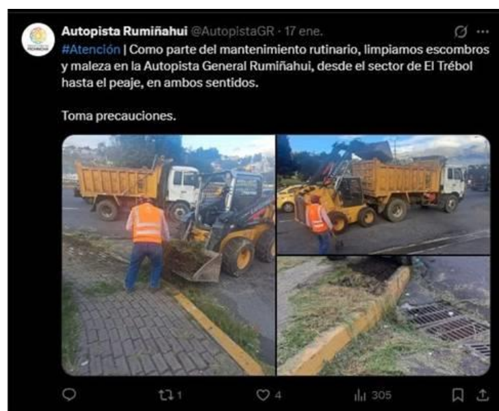
Figura 6. Publicación de obras de mantenimiento de la cuenta de la Autopista Rumiñahui
